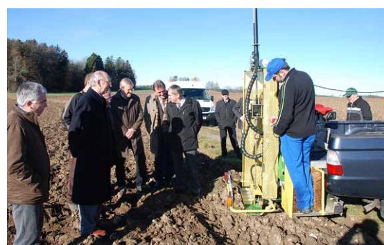
© Zweckverband Wasserversorgung Hallertau
